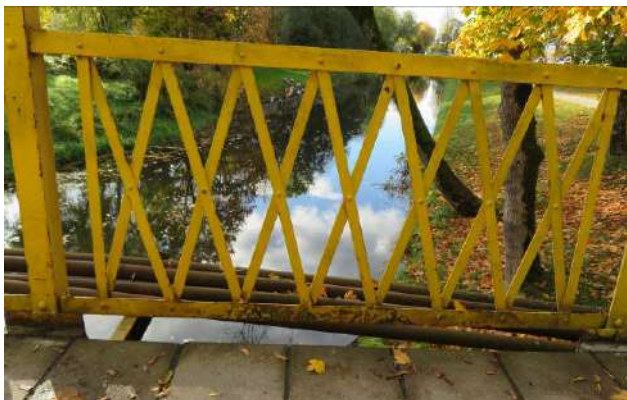
2.4 pav. Turėklų dažų danga nusidėvėjusi, koroduoja elementai
