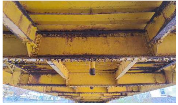
2.7 pav. Kiaura hidroizoliacija, šlampa ir koroduoja metaliniai elementai
