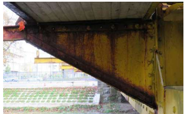
2.5 pav. Šaliteljius laikančios gembės labai pažeistos korozijos
