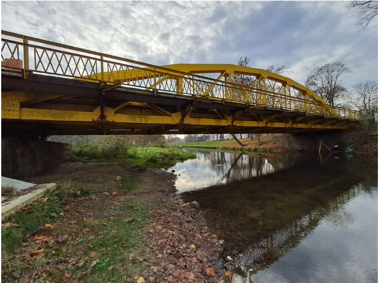
3.1 pav. Tilto perdangos sijų niveliacijos zona
