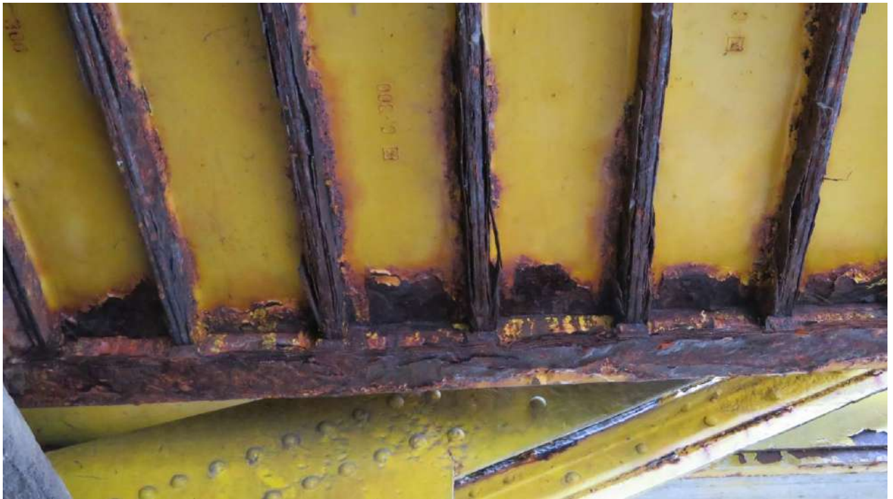
2.9 pav. Elementai labai paveikti korozijos, suplonėjęs metalo sluoksnis
