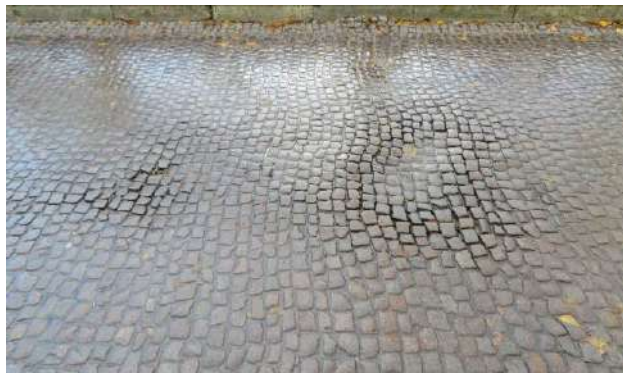
2.1 pav. Važiuojamoji danga nelygi, pasėdusios išsiklaipiusios plytelės
